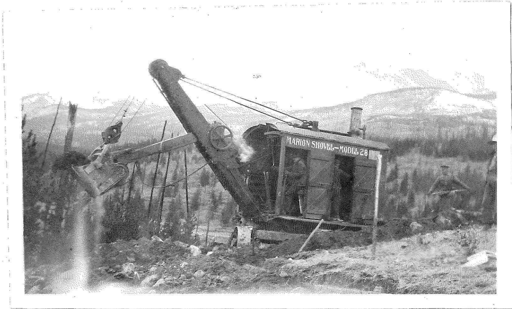
Steam-shovel on Castle-Laggan Road - Sta. 315.
